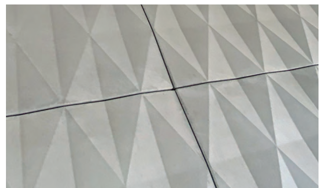
Taludplaten met ruitpatroon
