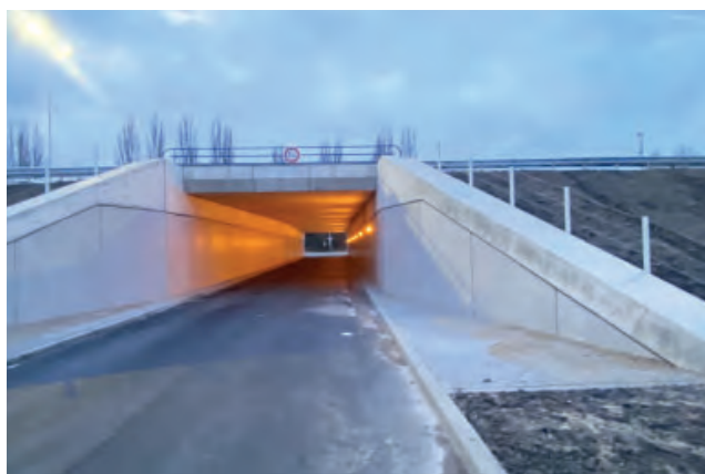
Huidige situatie Hofwijktunnel (K1)
