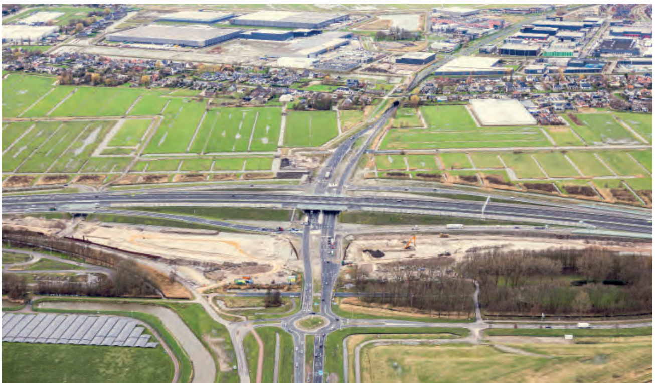
Provinciale weg N471 met Doenkadeviaduct (K20)
