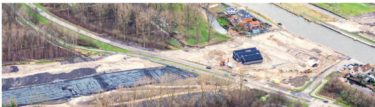
Luchtfoto huidige situatie - Dienstgebouw Zuid
