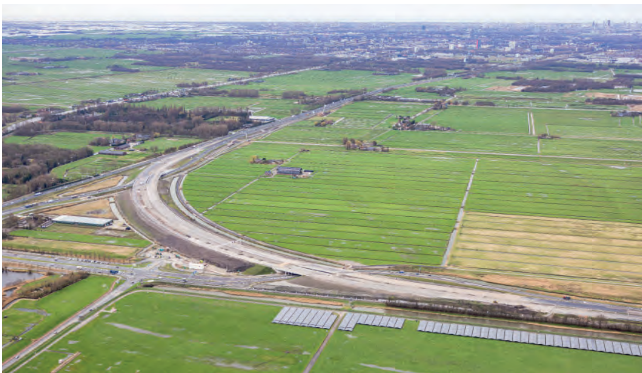
Luchtfoto verbingsboog A16 > A13 met viaduct afrit Vliegveldweg (K12)
