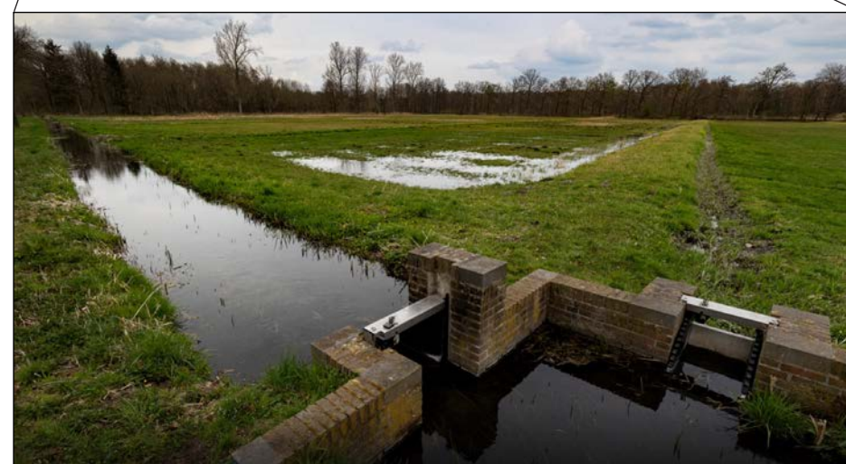
Fig. 104 Infiltratie beekwater via opgeleide waterloop
