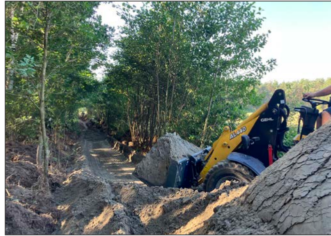
Fig. 39 Verondieping watgangen Vragender in het kader van EDDGI
